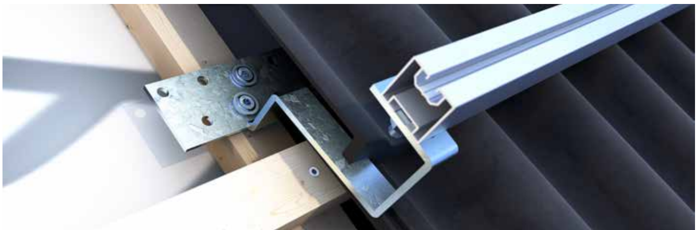
Dachhaken BASIC an der Konterlatte montiert, durch die ausgeklinkte Dachpfanne geführt und mit montiertem Montageprofil Steildach.
