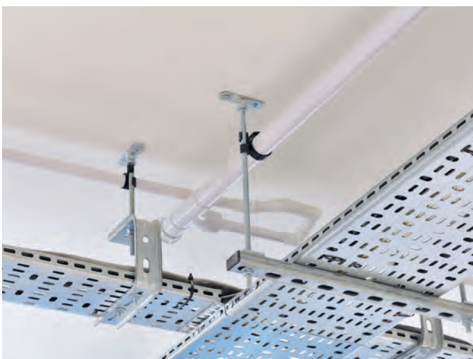
Perfekt für die Montage von Kabeltrassen und Wasserleitungen
