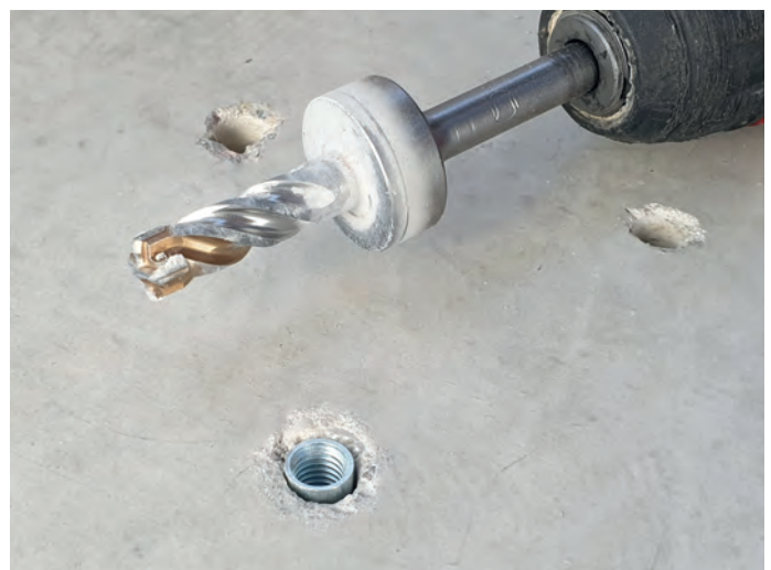
Zum Setzen von Einschlagankern
